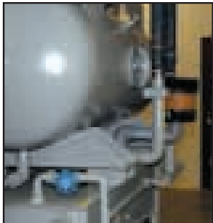
Respirador Watchdog® instalado en un tanque hidráulico.
