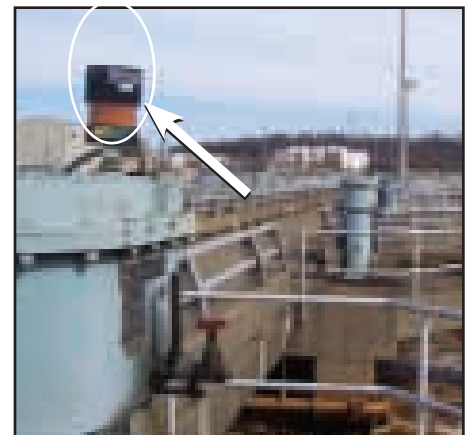
Respirador Watchdog® instalado en una caja de cambios en una facilidad de tratamiento de agua.
